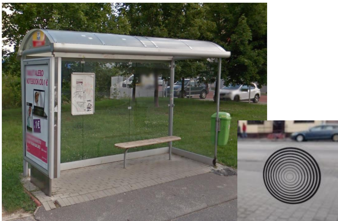
Obr. č.2 – Fotografia existujúceho prístrešku a detail ochrany proti nárazu vtákov
